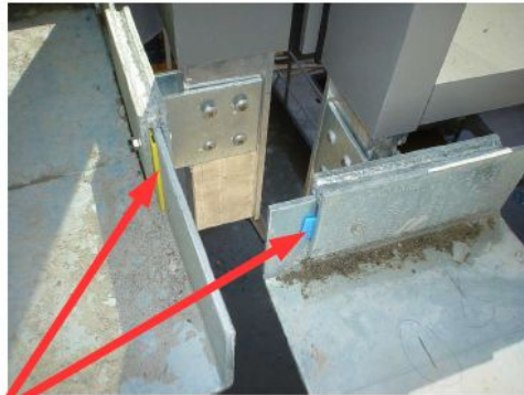
Plastové podložky nesmí být použity u nosných prvků.
