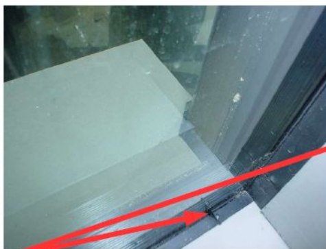
Přítlační lišty fasádního systému jsou provedeny nekvalitně, fasáda netěsní.
