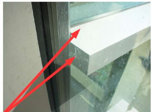
Chybí krytky dekorativního profilu včetně jeho fixace!!!!!!!!!!!!
