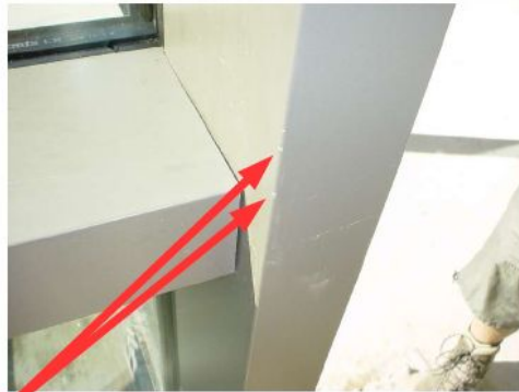
Poškozená povrchová úprava fasádního sloupku.
