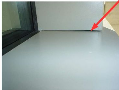
Poškozená povrchová úprava fasádního sloupku.
