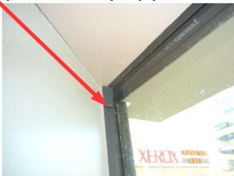
Spojení vnitřního těsnění není provedeno správně, konstrukce není paronepropustná.
