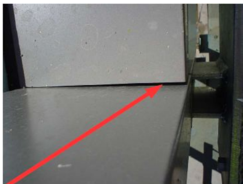
Křivě vyrobený či namontovaný příčnickový profil.
