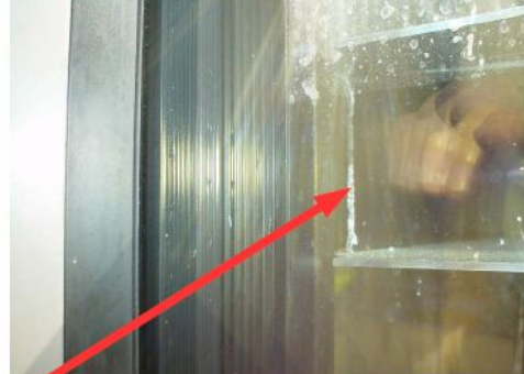
Neodborně provedený výřez – doporučujeme frézovat.
