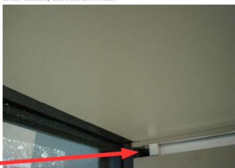
Přítlační lišty fasádního systému jsou provedeny nekvalitně, fasáda netěsní.
