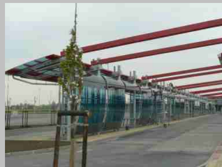
Stanice metra Letňany 2
