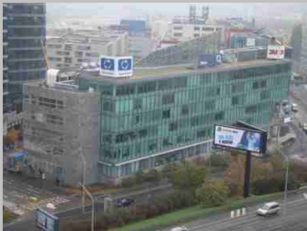
BB Centrum budova C
