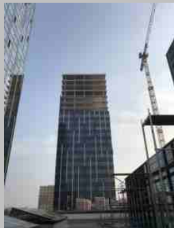
Komplex admin. budov Brno
