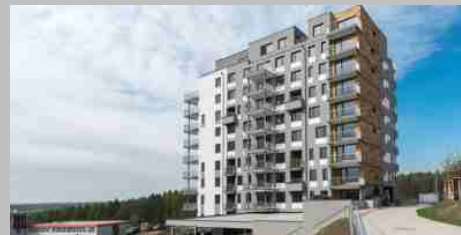
Byty Nad Pehradou_2
