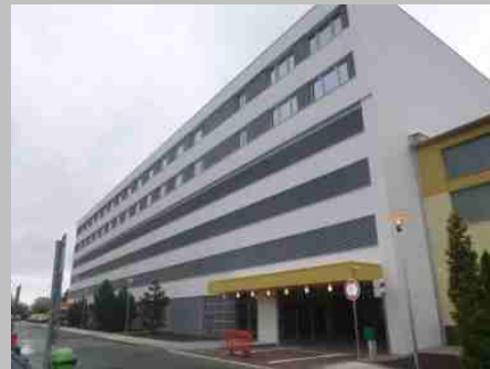
Polyfunkční objekt Praha 8_2
