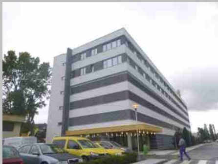
Polyfunkční objekt Praha 8_1
