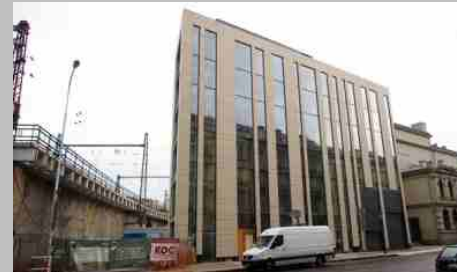
Admin. budova K71 Praha 2
