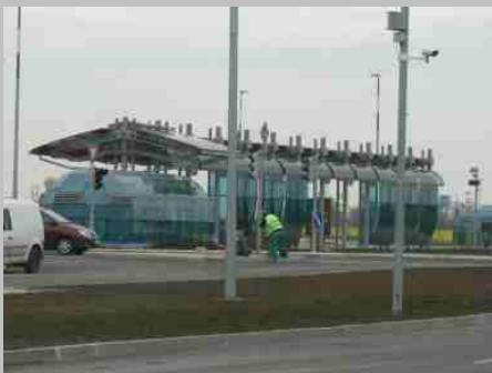
Stanice metra Letňany 1
