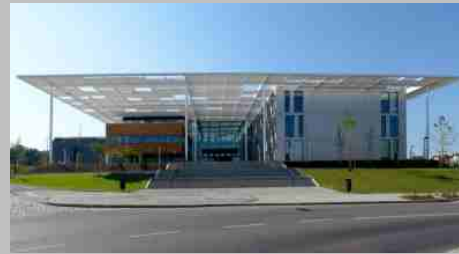
ELI Dolní Břežany_2
