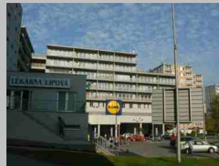
BYTOVÝ DŮM LIPOVÁ LB1
