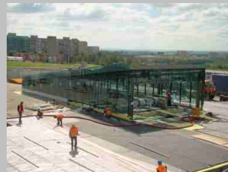
Stanice metra Střížkov
