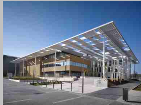
ELI Dolní Břežany_1
