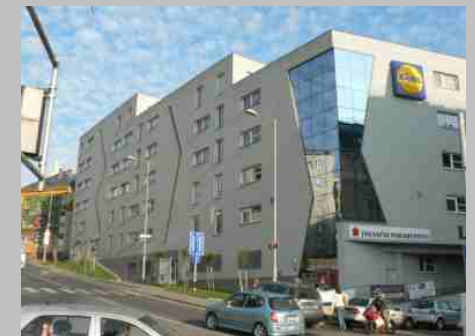
BYTOVÝ DŮM LIPOVÁ LB4
